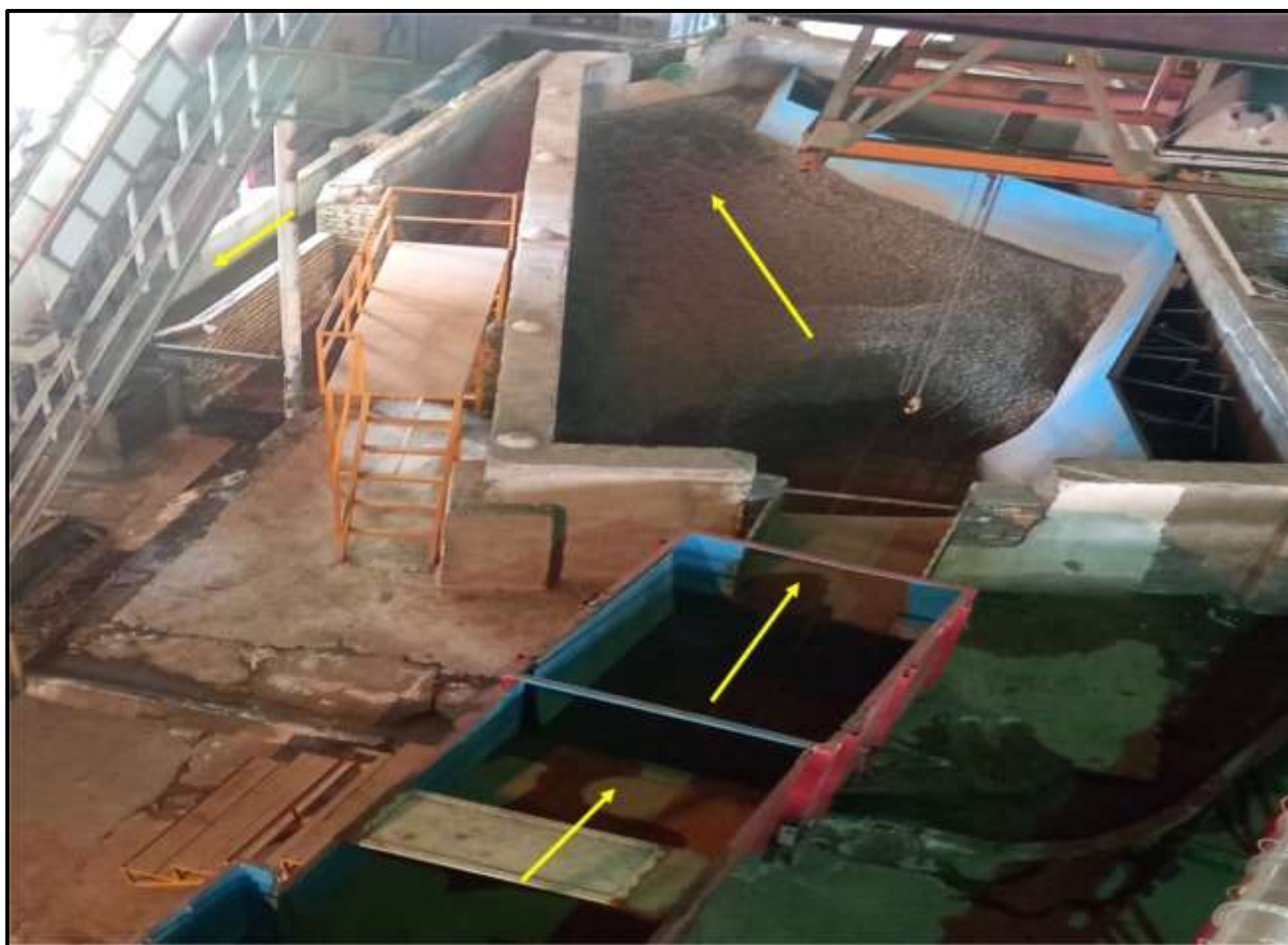
شکل ۱۱- نمایی از حوضچه استغراق پایین دست و مسیر نهایی انتقال جریان به سمت کانال اندازه گیری دبی
