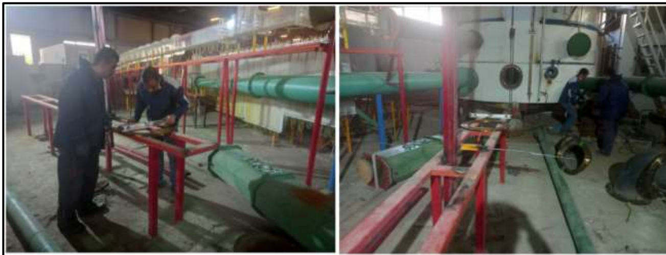
شکل ۶- اجرای شاسی فلزی جهت نصب تأسیسات مورد نظر روی آن
