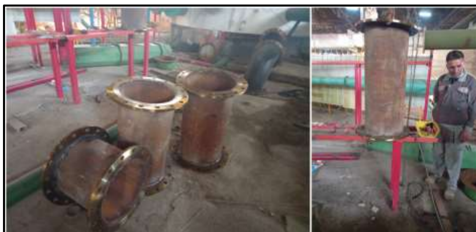
شکل ۷- تهیه و آماده سازی فلنج برای طرفین لوله ها
